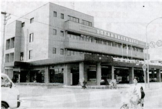
「消防緊急情報システム」を導入した4階建ての新消防局庁舎
