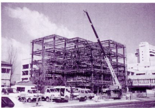
建設工事中の総合福祉センター (11月末日完成予定)
