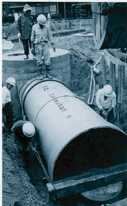
西品治地内に据え付けられる雨水管
