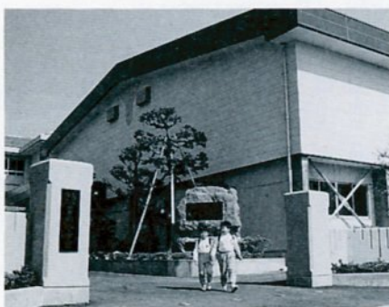
完成した富桑小の体育館
