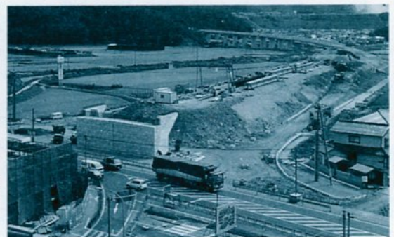
来年の開通をめざし工事が進む鳥取バイパス
