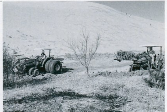
機械力を導入して進められる 鳥取砂丘の除草作業
