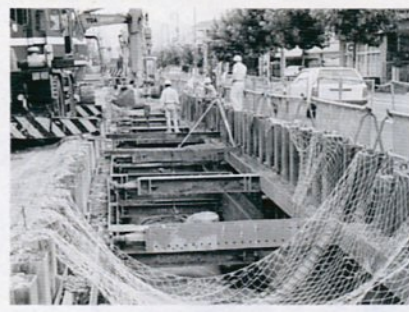
下水道管の埋設作業
