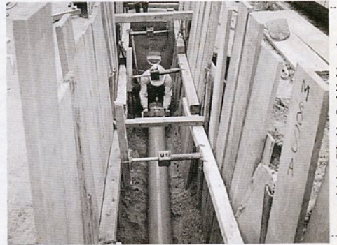
下水道の埋設工事
