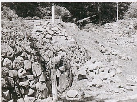
修理前の大菱櫓石垣
