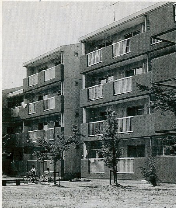
立川町6丁目の旭町住宅
