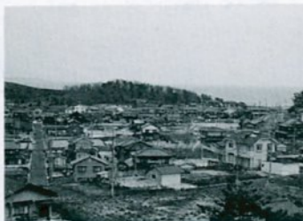
整備が終わった賀露地区
