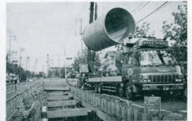
下水管埋設工事
