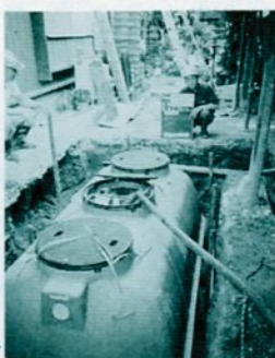
合併処理浄化槽の設置工事
