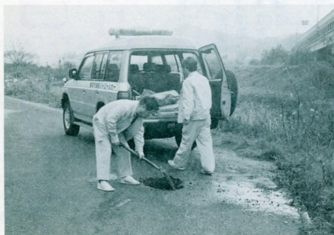
陥没補修作業
