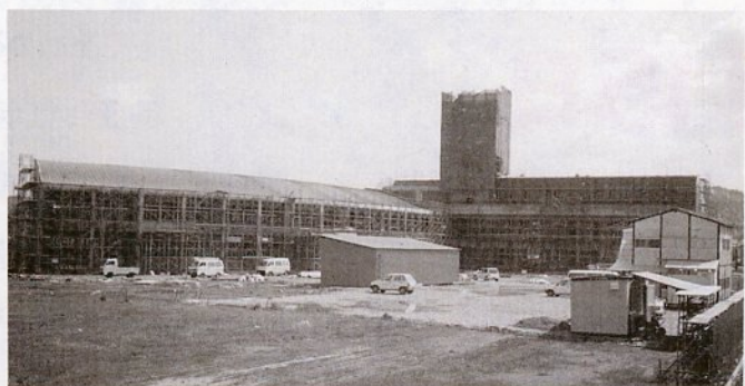
着々と工事が進む 若葉台小学校
