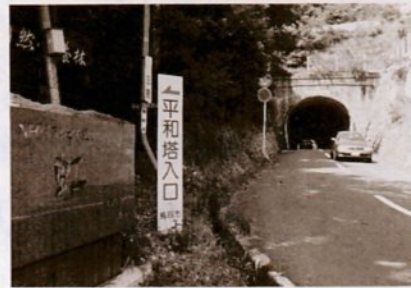
円護寺トンネル付近
