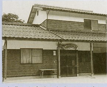
完成した高路ふれあいセンター
