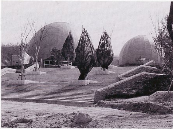
工事が進む出合いの森
