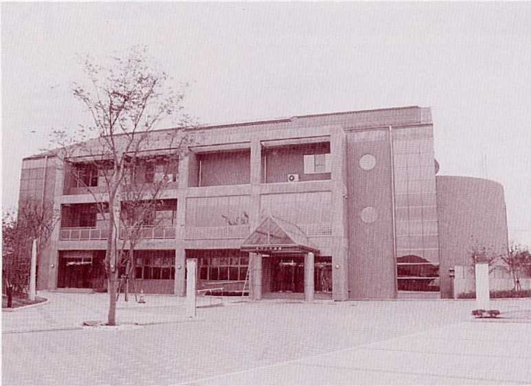
水道局新庁舎
