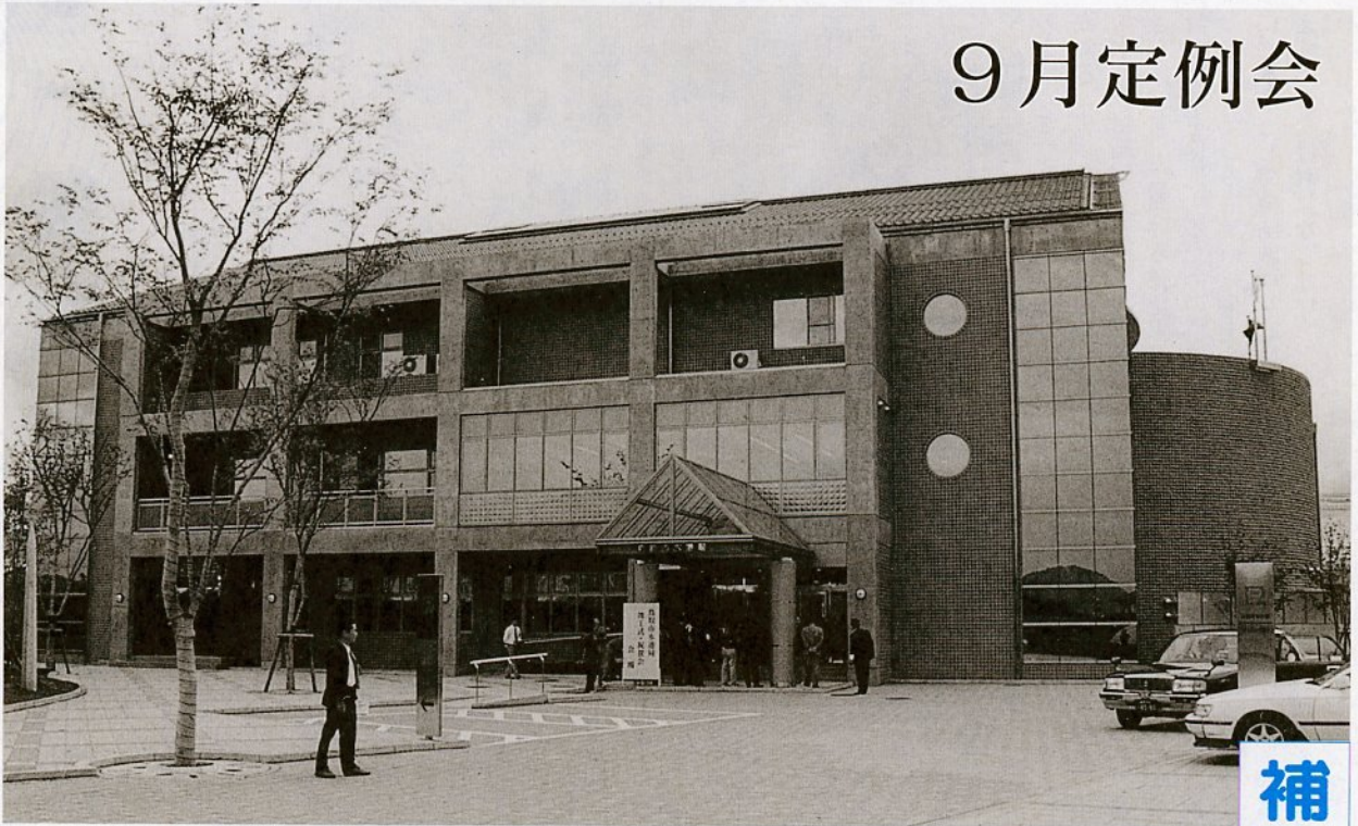
十月一日移転開業した水道局新庁舎
