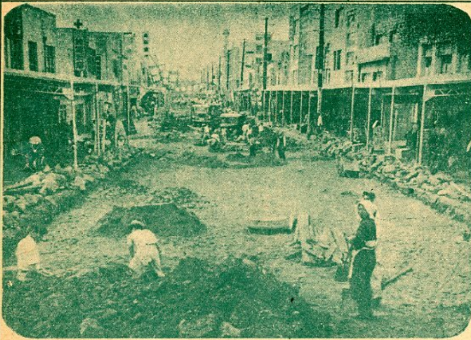
若桜街道舗装 待望の舗装が藤原組と日本舗道の昼夜兼行作業により、美し防火ビル街を貫く竣工も真近。延長八一五米。総事業費はなんと一六六九万円。(写真は工事中の街並)
