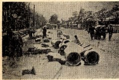
東町法務局前地下水管の敷設
