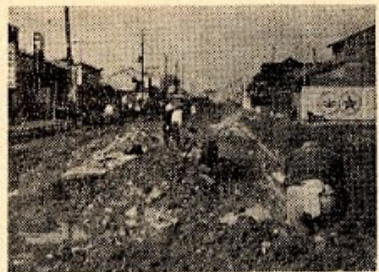
工事のすすむ片原線の街路舗装
