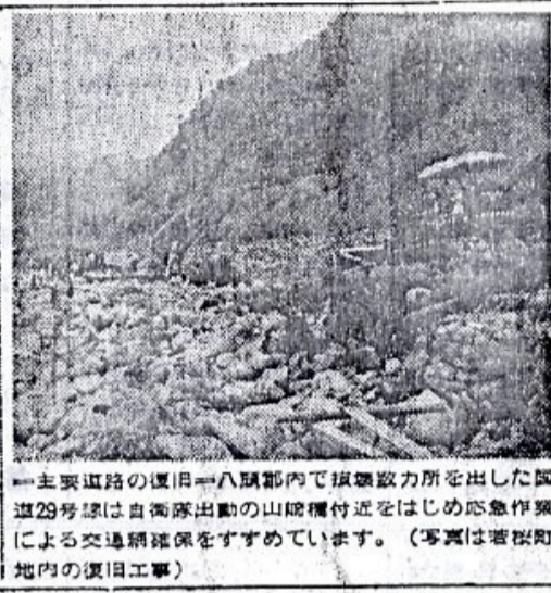
一主要道路の復旧一八郡管内で復旧作業所を出した国道29号線は自衛隊出動の山崎村付近をはじめ急修作業による交通確保をすすめています。(写真は若狭町管内の復旧工事)
