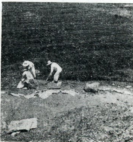
ノリの増殖用セメント張り工事
