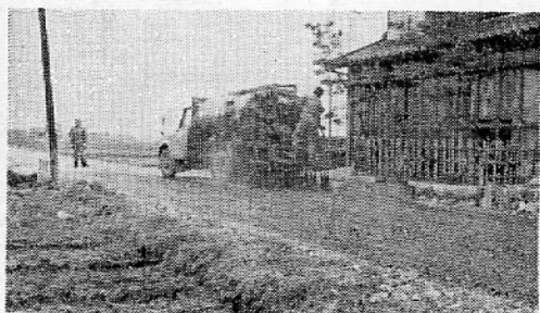
農道の簡易舗装（岐阜市にて）
