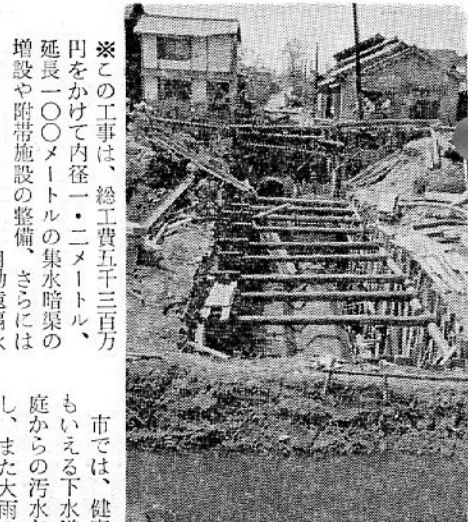
袋川汚水幹線伏越工事
