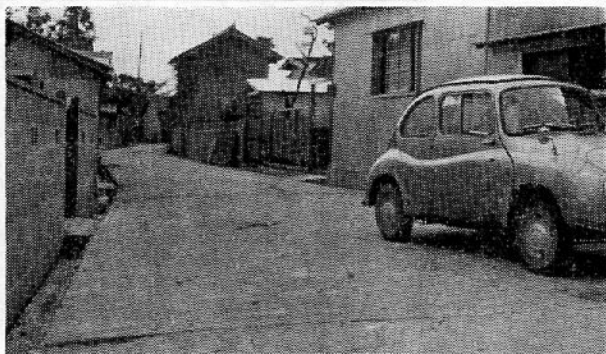
完成した古市地内の市道
