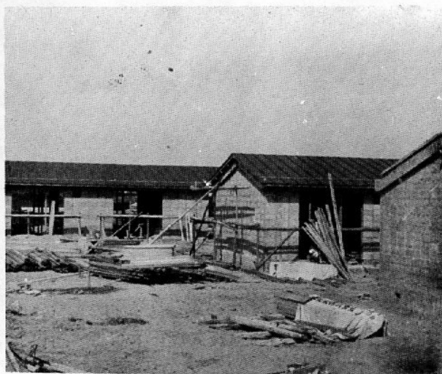
完成間近い湖山町の市営住宅
