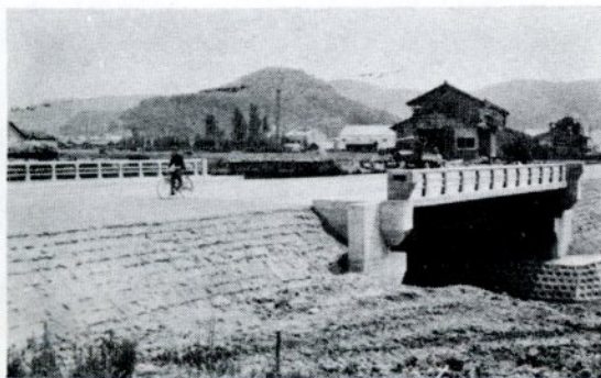
完成した三洋大橋 (簡易保険積立金還元融資による)
