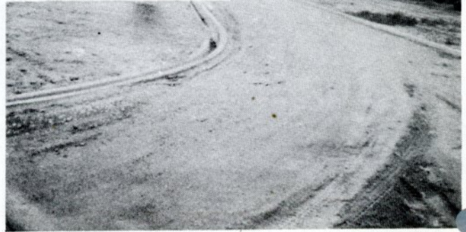
(造成中の工場団地)
