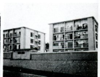
湖山地内に建設された市営住宅
