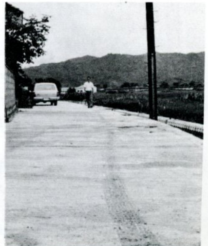
好評の部落内舗装 (橋本にて)
