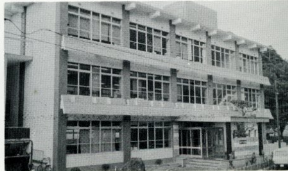
水道庁舎 上町の元公会堂跡地に、工費約3,500万円で完成。積極的に水道事業の拡張に取り組む。
