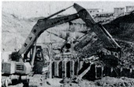
源太橋下流約400メートルの右岸堤防を切り割りし、1200ミリの導水管を布設中。手前円筒形のは接合弁
