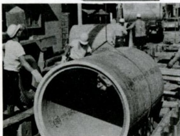
すすむ下水道管敷設工事
