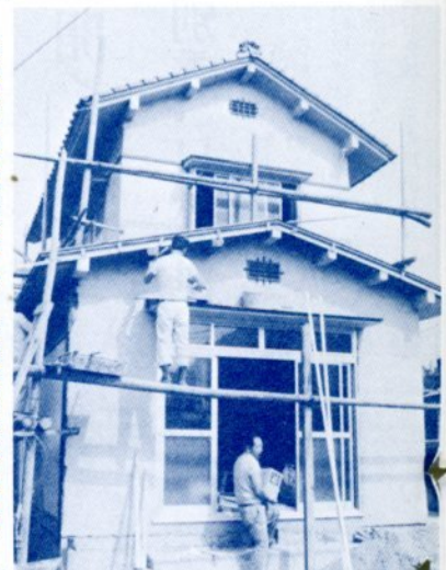
宅地分譲を受け、念願のマイホーム建築中(旧大森町四区)
