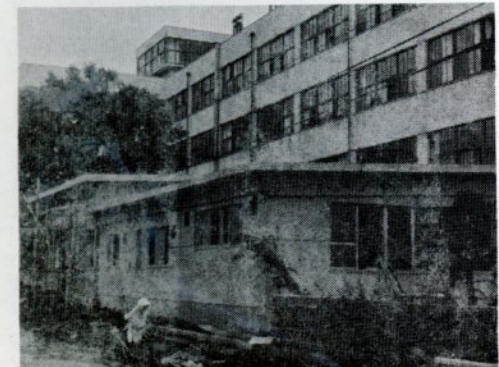
本館北側のオープン間近いリハビリテーション施設
