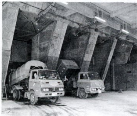
三階にあるごみ投入室、収集車が四台同時に投入できる
