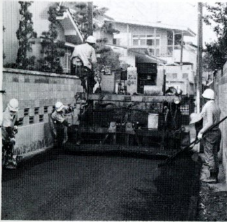
舗装中の市道（西町地内）
