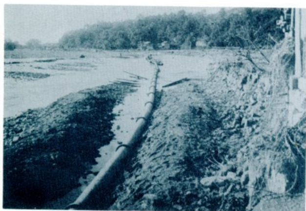
大正7年9月 大洪水により送水管が河川内へ流される 国府町町屋
