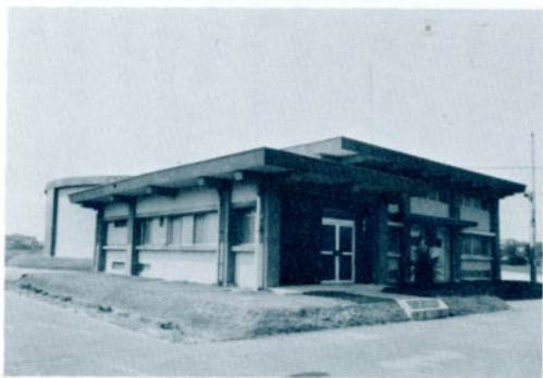
賀露ポンプ場
