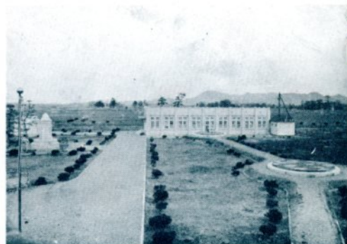
旧国安水源地
