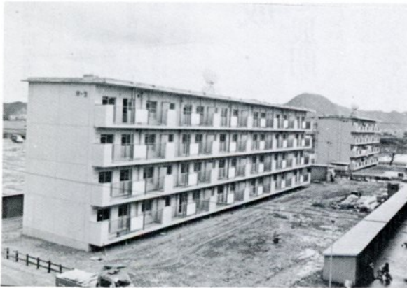
▲完成間近の徳吉市営住宅「R-9」棟
