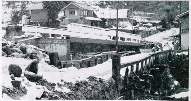
▲木橋（手前）をかけ替え。長さ17.45mの永久橋に……
