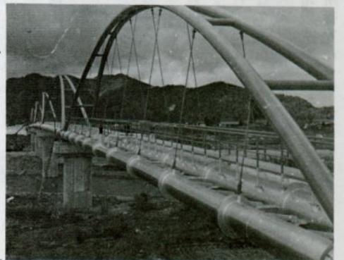
アーチ型の千代川水管橋
