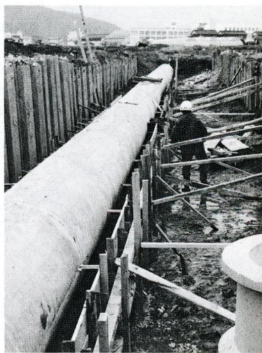
直径90センチの下水道管の敷設工事 (田島地内で)
