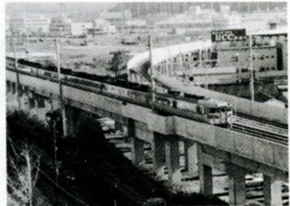
高架になった山陰本線 (因美線一右一との分岐点付近)
