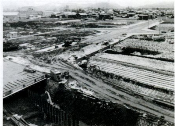
道路築造がほぼ完了した田島土地区画整理事業。左手前が狐川にかかる橋(工事中)で、道路は幅員二十二メートルの西品治田園線(建設省鳥取工事事務所から)
