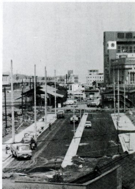
工事の進む都市計画道路停車場卵垣線。幅員23～25メートルで、4車線道路となる。中筋の立体交差までは56年3月に完成予定
