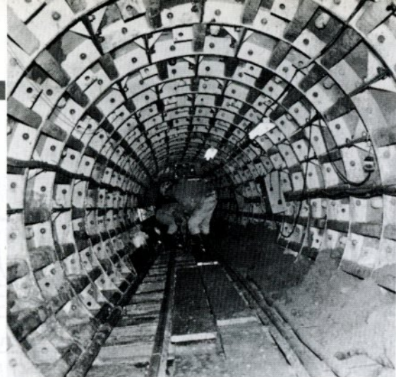
シールド工法で工事が進められている秋里汚水2号幹線(処理場前)
