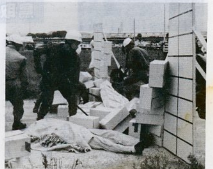
倒壊したブロック塀を除去して救護
