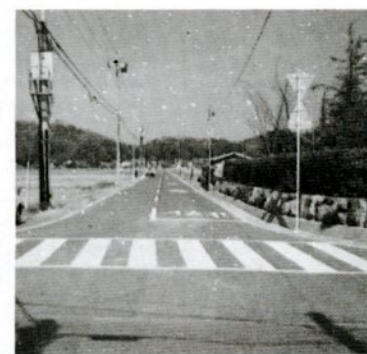
整備された地区内の農道
