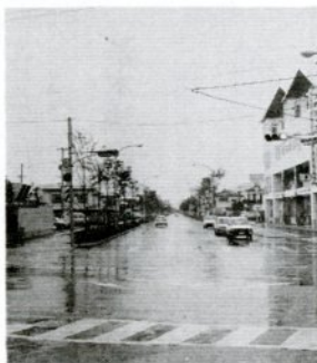
都市計画道路西治田園線 60年に供用開始した
