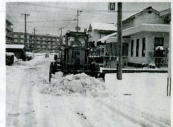
除雪ドーザによる除雪作業
