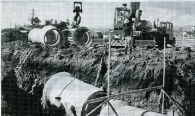
家庭などの排水を送る 下水道本管工事
