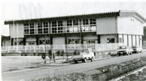
完成した江山中の屋内運動場
