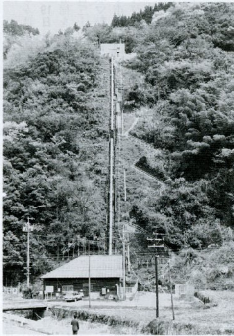
明治40年に完成した荒舟発電所
