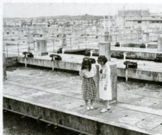
下水に活性汚泥と空気を送り込むばっく槽
