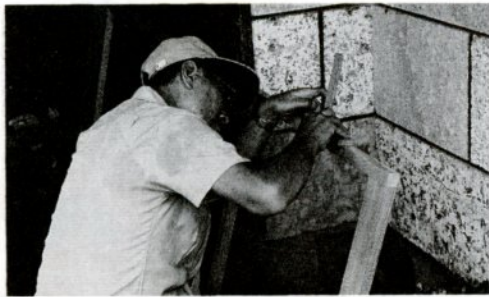
小修繕事業で網戸の取り付け作業を行うシルバーの会員
